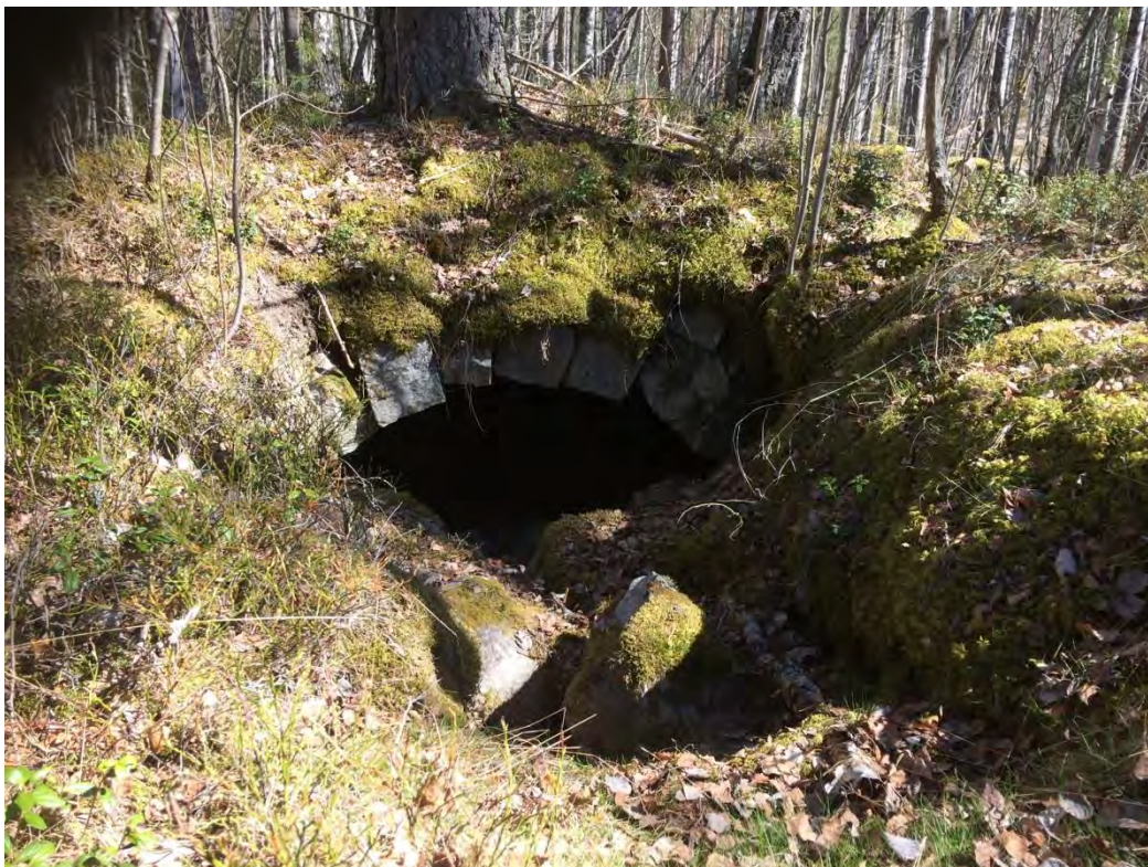
Bebyggelselämning med gammal jordkällare norr om Bergsgården. Foto E. Röing 2017.
