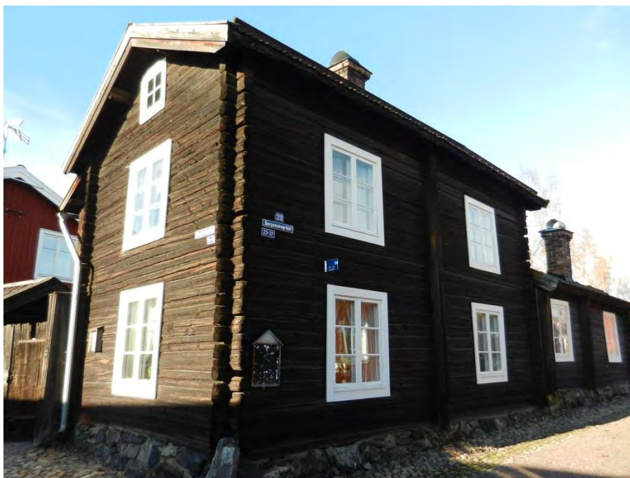
Gården Vass-Britas med sina av svaveldioxid svärtade fasader, i stadsdelen Gamla herrgården.
